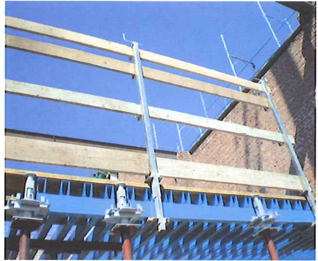
Parapetto di sicurezza
